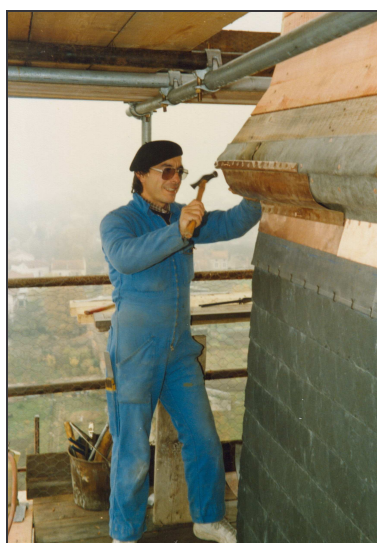
Réfection de la couverture.
