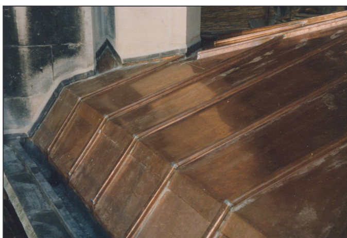
Détail de la toiture de cuivre du bas-côté nord du chœur.
