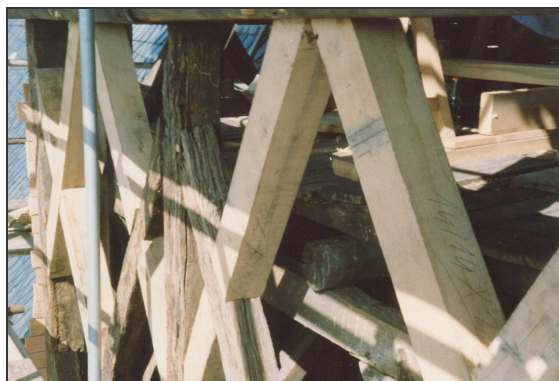
Renforcement de la charpente.
